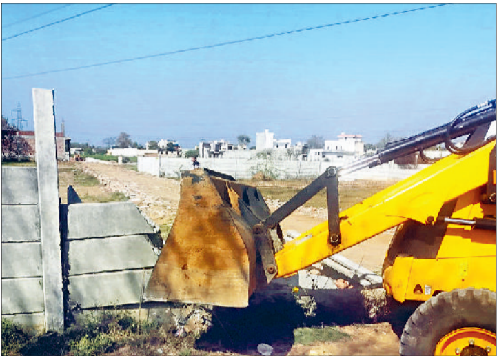
रेवाड़ी। गोकलगढ़ में अवैध कॉलोनी का निर्माण तोड़ती जेसीबी व पटौदी रोड पर अवैध कॉलोनी का निर्माण तोड़ती जेसीबी।
