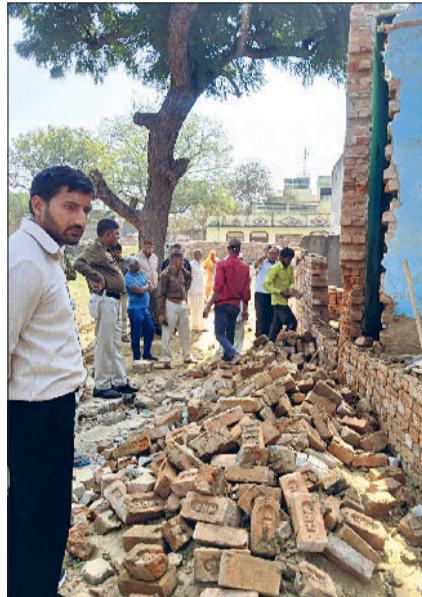
रेवाड़ी। गांव गादला में प्रशासन की ओर से तोड़ा गया अवैध निर्माण, अवैध कब्जे हटाने की कार्रवाई में मौजूद पुलिस।
